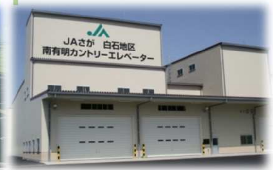
共同乾燥調製貯蔵施設
